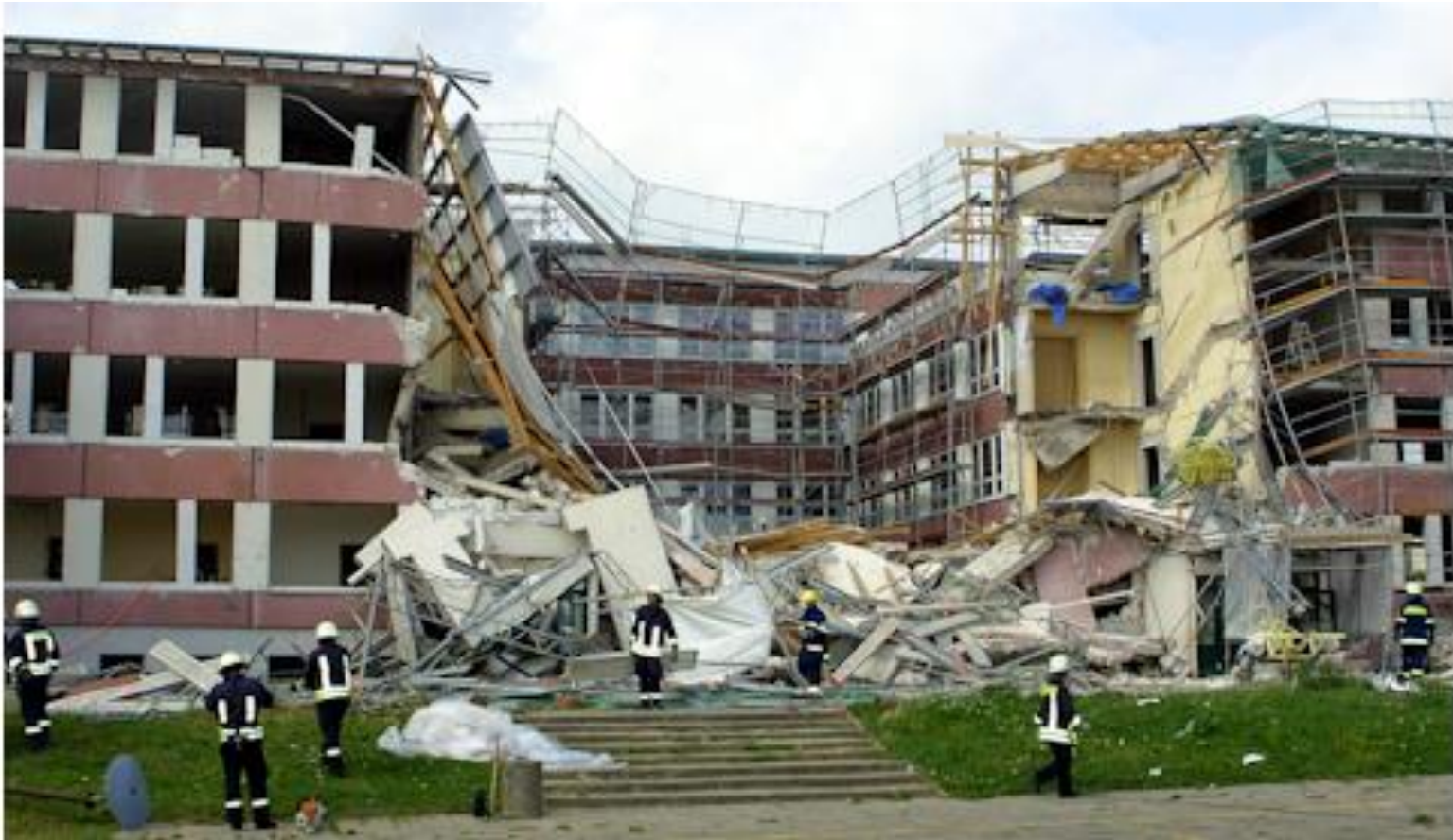
Cinq morts pendant l'écrroulement partiel de l'école Goldberg, Allemagne 2004
