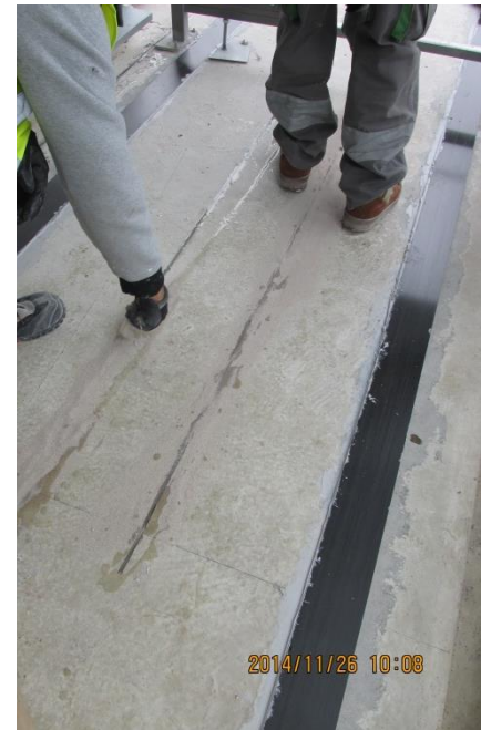
Mise en place des armatures passives
