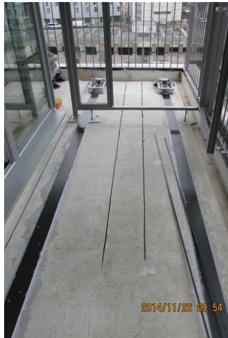
Mise en tension des lamelles
