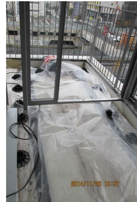
Mise en place du chauffage
