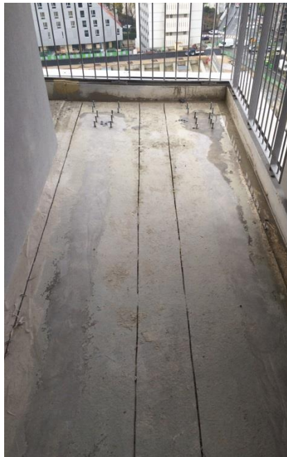
Préparation des systèmes de précontraintes et des rainures
