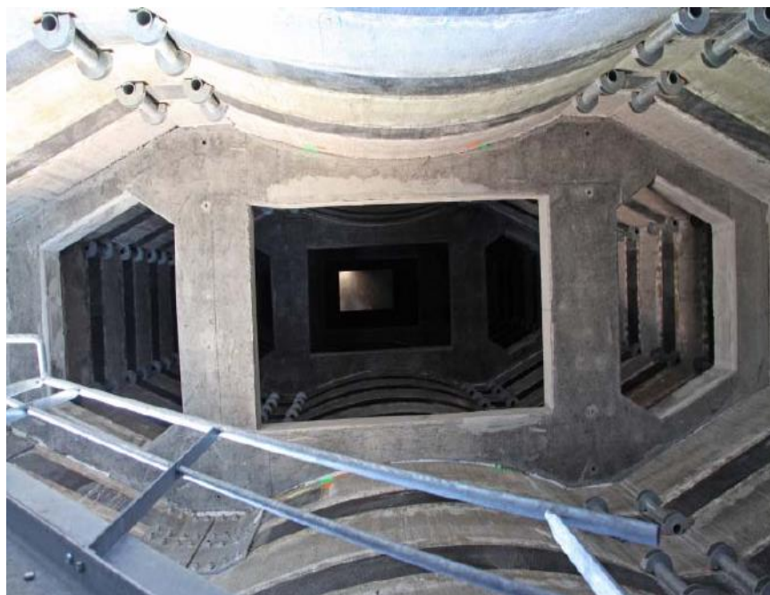
Vue intérieure d'une pile renforcée
