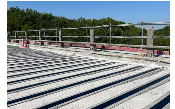
Renforcement du tablier - Viaduc du Courteineau - Saint-Epain, France
