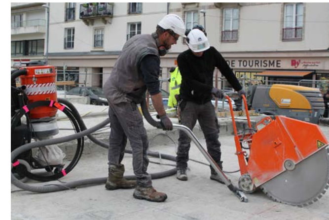
Renforcement de structure existante - Parvis des Halles - La Roche sur Yon, France
