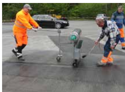
4 Application manuelle de la grille d'armature S&P pour les renforcements locaux
