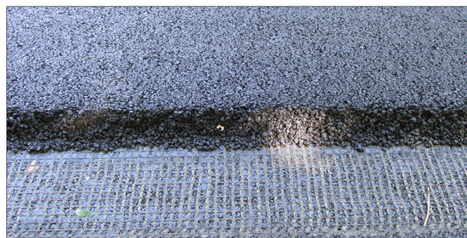
▲ Application de l'enrobé
