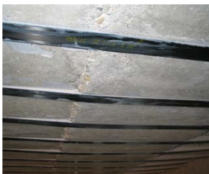
▲ Détail du reprofilage avec S&P Resin 230 dans la zone d'un rebord de plafond
