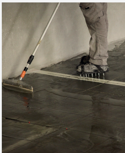
▲ Zone en cours de renforcement
