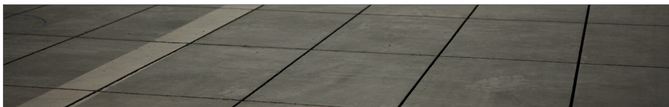
▲ Zone sciée prête à être renforcée
