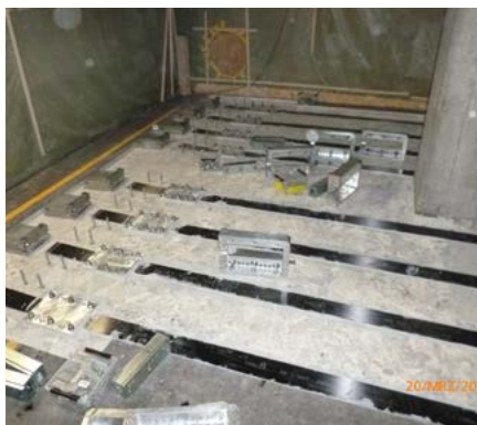
▲ Installation des ancrages d'extrémité / Enlèvement de l'unité de serrage / Coupe à la longueur du stratifié
