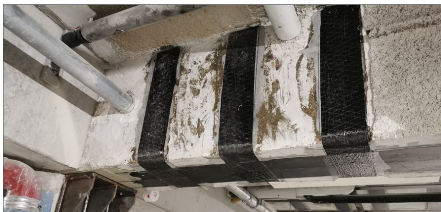
▲ S&P C-Sheet (Poutre renforcée à l'effort tranchant)
