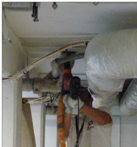
▲ Vue du système de mise en tension, encombrement extrêmement limité en phase temporaire, S&P Lamelle C-Laminate précontrainte permet une grande souplesse dans son utilisation.
