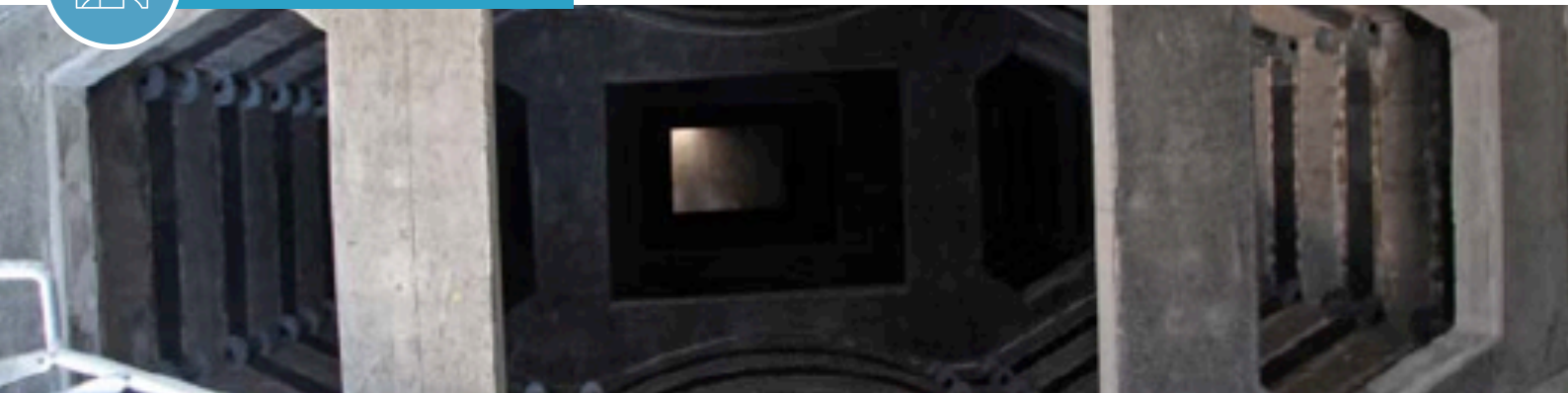
Vue de l'intérieur de la Pile renforcée avec tissu S&P C-Sheet 240 et déviateurs ▲
