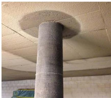
▲ Support recouvert avec du sable de quartz pour absorber le mortier de protection.
