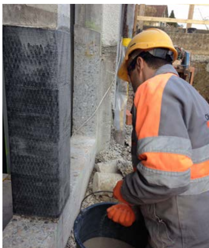
▲ Recouvrement des colonnes avec du sable de quartz comme couche d'accrochage
