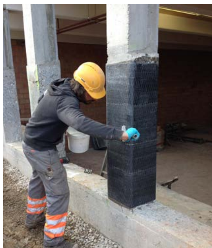
▲ Stratification de la S&P C-Sheet 240 400 g/m 2 avec S&P Resicem (perméable à la vapeur)
