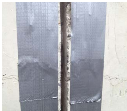
▲ Implantation et traçage/ fraisage/ collage les fentes verticales (profondeur 25 mm)
