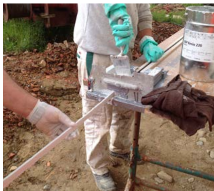
▲ Application de résine S&P Resin 220 sur les lamelles nettoyées
