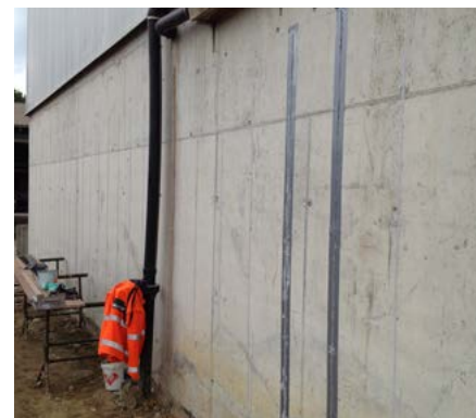
▲ Mur extérieur renforcé terminé
