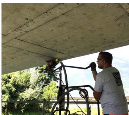
▲ La préparation comprenait le marquage et le ponçage du support en béton à l'aide d'une meuleuse à grande capacité
