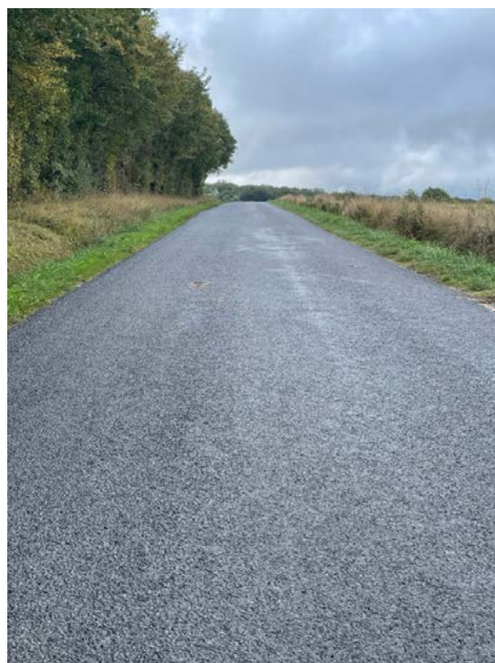
Figure 4 : Etat de la chaussée en octobre 2023, aucune fissure est repérée ▶
