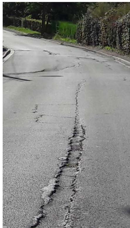
▲ Figure 1.b: Etat de surface de la chaussée avant réfection, année 2019 : Faiençage, fissures longitudinales, tassement différentiel
