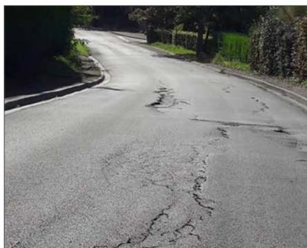
▲ Figure 1.a: Etat de surface de la chaussée avant réfection, année 2019 : Faiençage, fissures longitudinales, tassement différentiel
