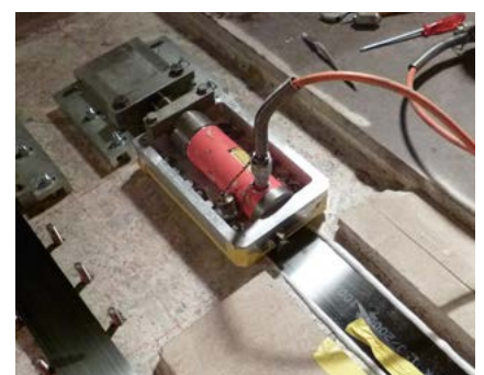
S&P C-Laminate précontraint (renfort à l'État Limite de Service)
