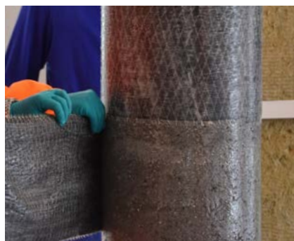
Renforcement à la charge axiale des poteaux avec S&P C-Sheet 240
