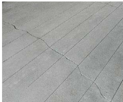
Renforcement à la flexion avec des S&P C-Laminates engravées
