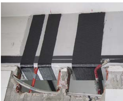
Renforcement du à l'effort tranchant avec S&P C-Sheet 640
